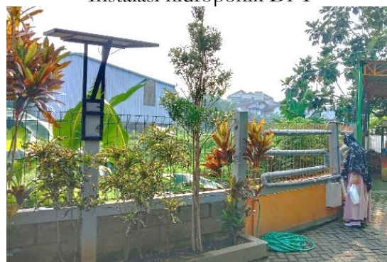
Gambar 1: Instalasi hidroponik DFT
