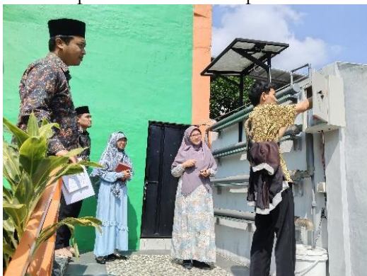
Gambar 3: Pemasangan instalasi Listrik yang bersumber dari panel surya yang terintegrasi pada instalasi hidroponik
