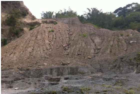
Foto Lapangan: Bekas Longsorlahan di area tambang pasir Desa Sidorejo Kec. Kemalang
